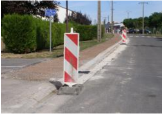
Réfection de trottoirs rue des Fontangues
