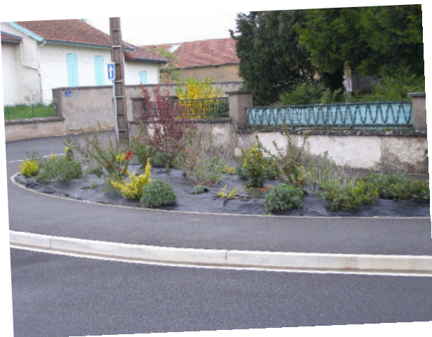
Terre plein à l'angle de la rue de la Maternité et la rue des Cens
