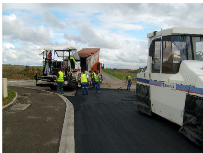
Pose des enrobés sur la voirie de la ZAC, le 8.09.2010
