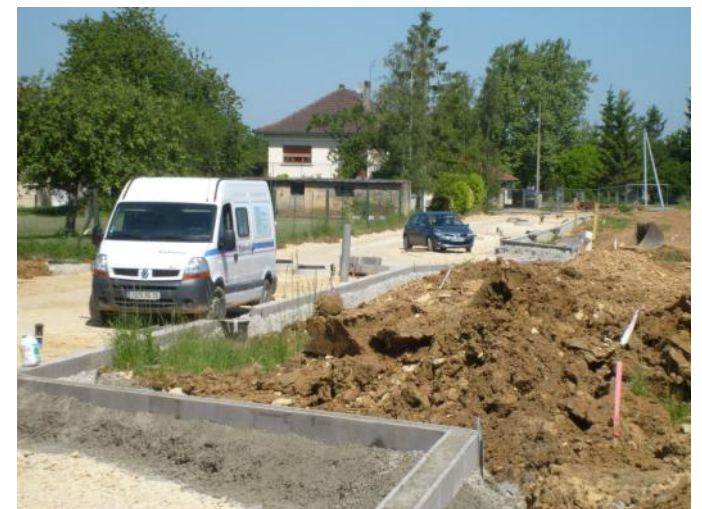
Les travaux au lotissement de Riéviliers avancent bien. Ici la pose des fondations en bordure de parcelles
